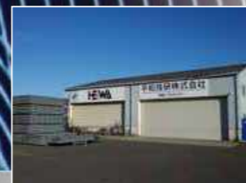
宮城レンタルセンター
